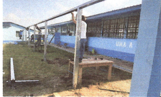
Foto 2: MODULO 2. igual manera que este módulo ya lleva el 50% de avance
