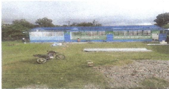
Foto 1: MODULO 1. se observa que este módulo ya está lijada y pintada la costanera.
