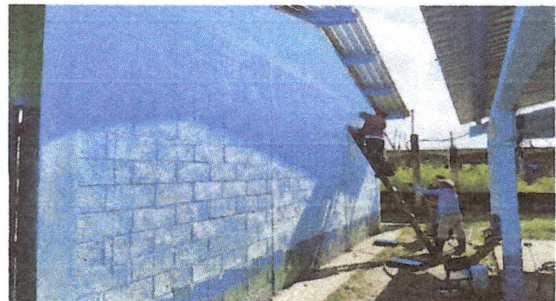
Foto 4: MODULO 4. se observa el trabajo que la pintura ya lleva el 70% de avance
