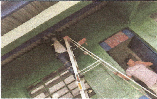
Foto 3: MODULO 3. Este módulo lleva el 50% de instalación de avance.
